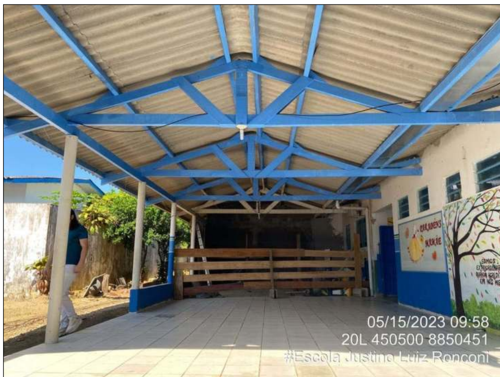
Figura 3: Vista de tesouras existentes a serem retiradas, com reaproveitamento Local da Nova biblioteca.
