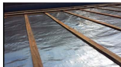
Manta aluminizada nas duas faces, para subcobertura, e = *2* mm
